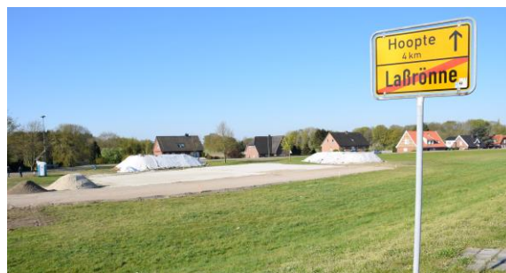
Foto: Baustelle Feuerwehr / DGH am Elbdeich
