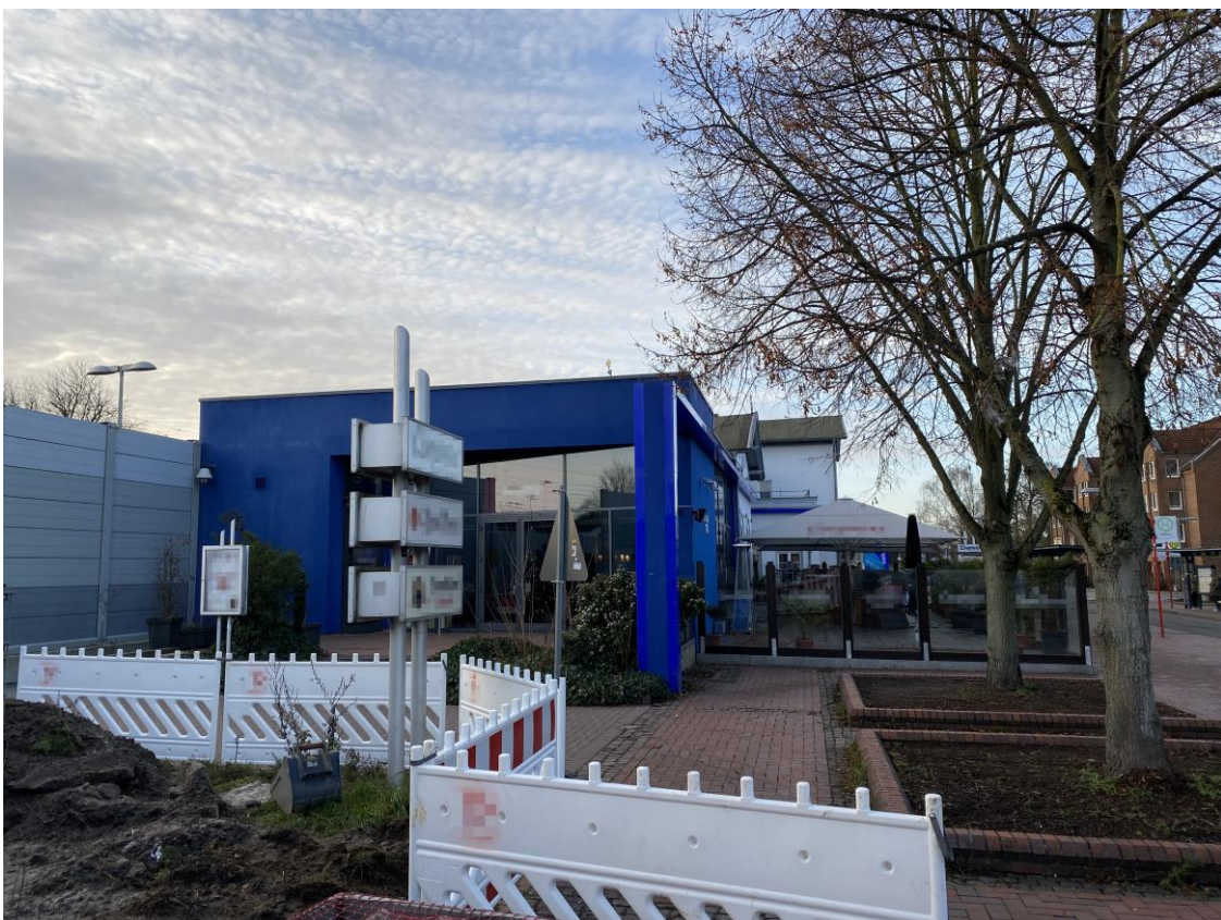
Bild 2: Von den Tiefbau- und Umgestaltungsmaßnahmen betroffener Bereich.
